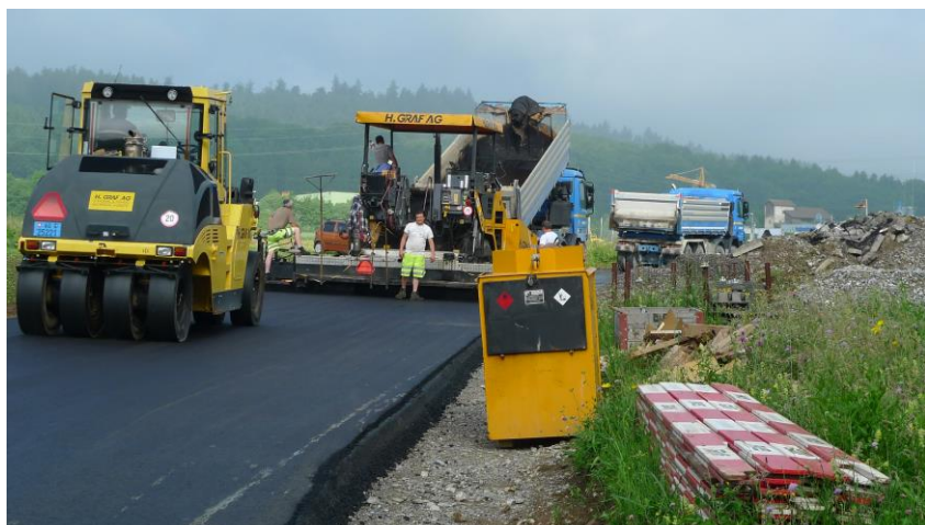
Hochbetrieb während der Bauphase
