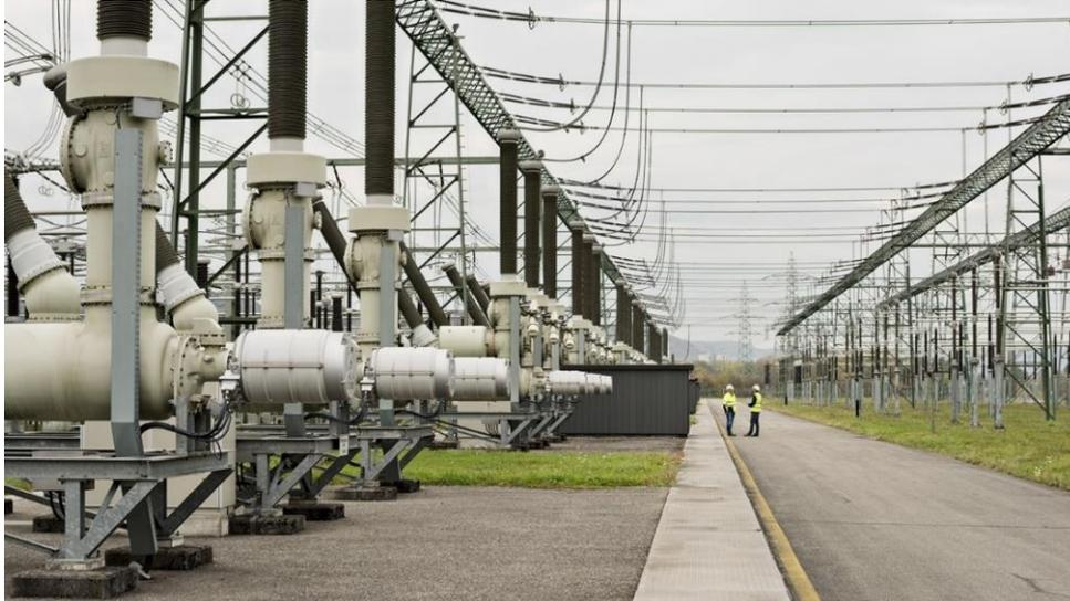
*Nach der Inbetriebnahme der neuen gasisolierten Schaltanlage wird die bestehende Freiluftschaltanlage grösstenteils rückgebaut.*
