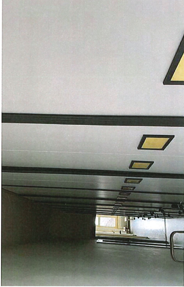
Archiv 1.OG, Estrich, Dach über Anbau (Bibliothek)
