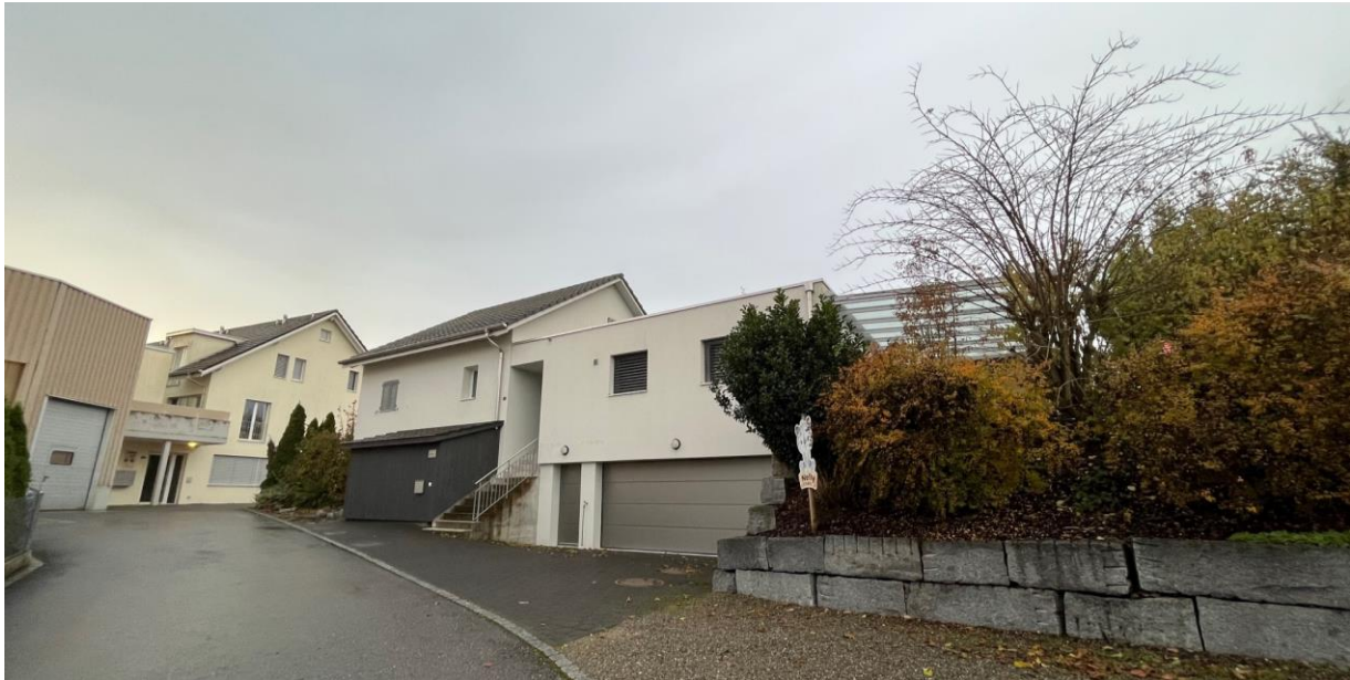
Ansicht Gebäude Mühleweg Nr. 7 mit Zufahrt über die Parzelle Nr. 903
