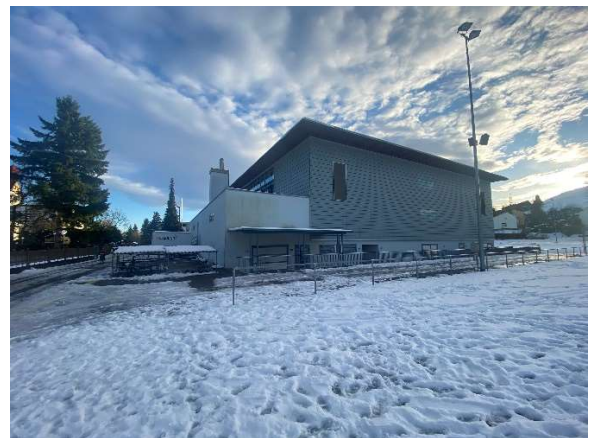
Turnhalle und Nebenräume
