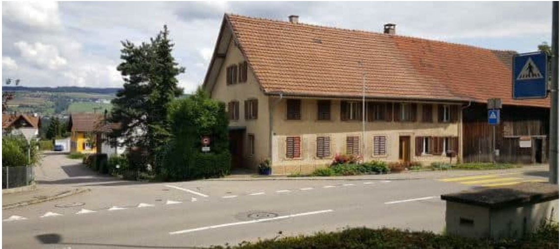
Abbildung 9 Einmündung Hubelstrasse in Hauptstrasse
