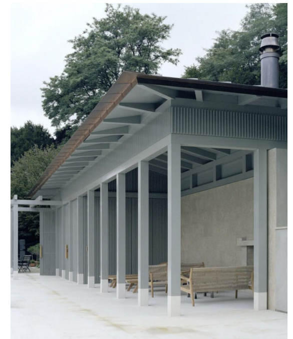
Poolhaus - Vécsey Schmidt Architekten
