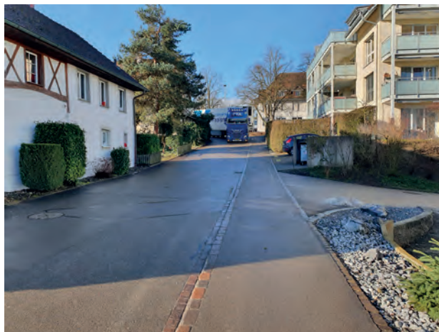
Die Hubelstrasse dient als Erschliessungsweg für die Gärtnerei, Lastwagen fahren im Einbahnverkehr.
