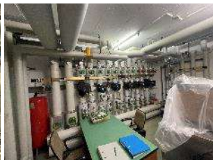
Heizverteiler / Gruppenverteiler 8
