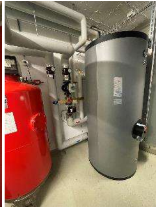
Warmwasserspeicher 7
