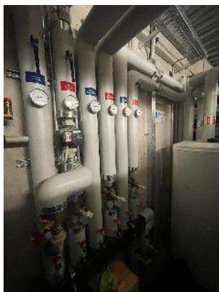
UST Heizverteiler
