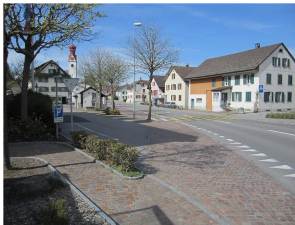
Hauptstrasse im Bereich Bushaltestelle «Zentrum»
