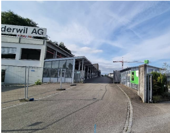
a) Gebäude ehem. FFN und Privatstrasse (Gebäude in der Zwischenzeit abgebrochen und Ersatzgebäude in Erstellung)
